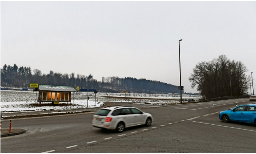
Erst wenn der Kreisel beim Abzweiger nach Sulz fertig ist, darf die Deponie betrieben werden.
